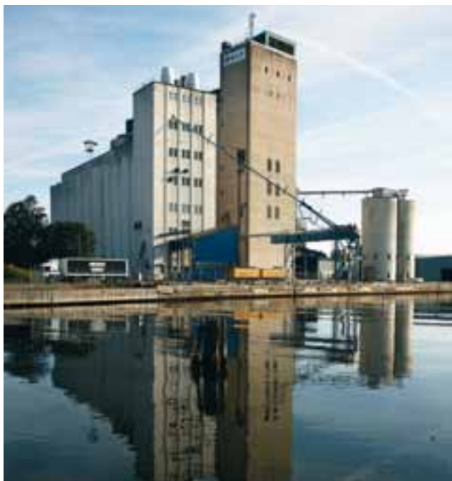
KLF investerade i en ny intagningshall vid anläggningen i Åhus.
